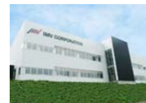
東京テストラボ 上野原サイト 高度試験センター
