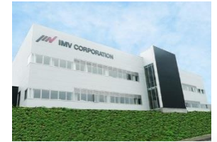
東京テストラボ 上野原サイト 高度試験センター
