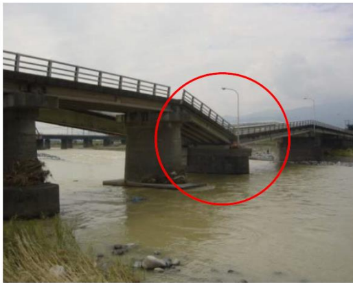
橋脚の洗掘・沈下
