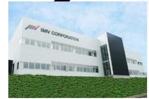
東京テストラボ 上野原サイト 高度試験センター
