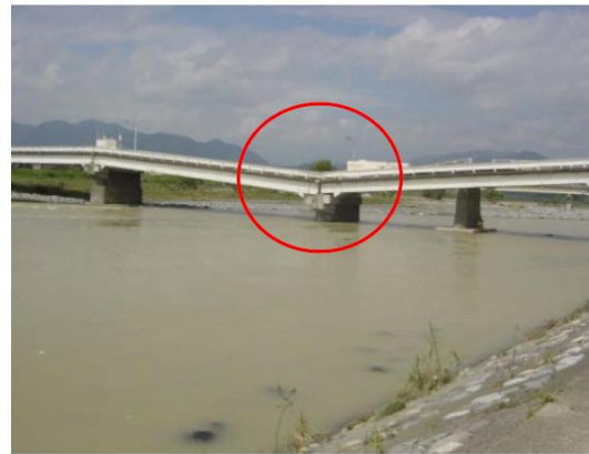
橋脚の洗掘・沈下
