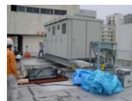
ビルの耐震性評価
