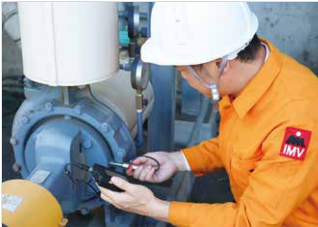
泵的测量场景
