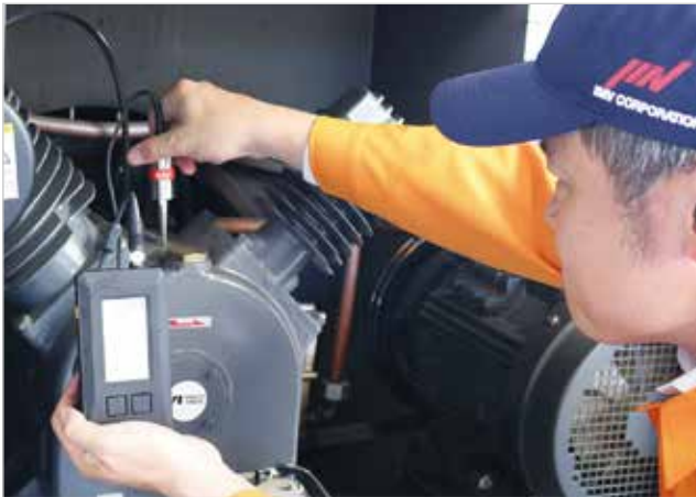
压缩机的测量场景
